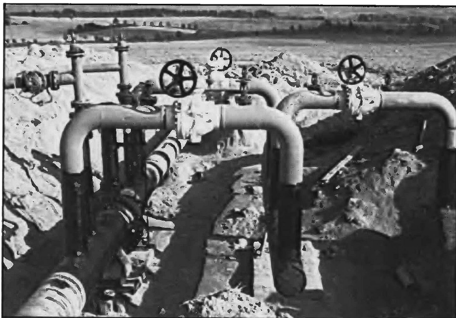
Obrázek č. 4. Nově zrekonstruovaný uzel Obrataň před dokončením zemních prací
