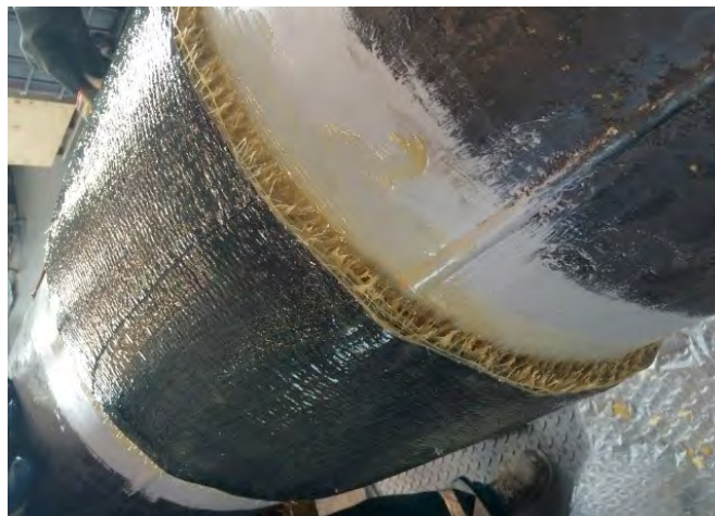
Obr. 3 Vinutá kompozitní objímka s 5x více vrstvami, než uvádí výrobce [1]
