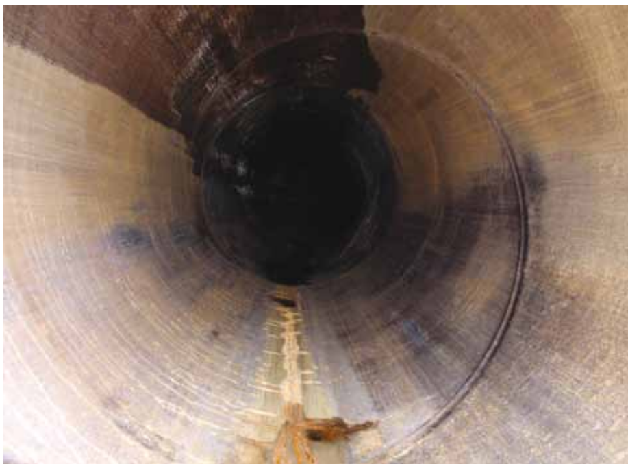
Obr. 2 – vnitřní stěna potrubí po dekontaminaci
