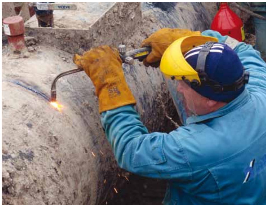
Obr. 4 – řez plamenem v již trvale bezpečné atmosféře
