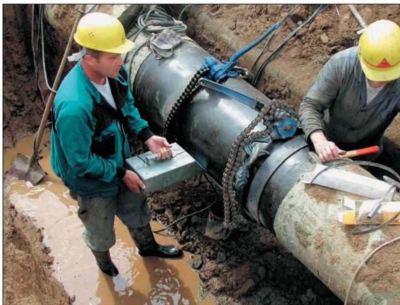
Instalace ocelové objímky
