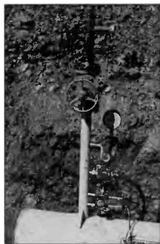
Obr. 3. Tlaková reparace (sružená napouštěcí, tlakovací a měřicí místo)
