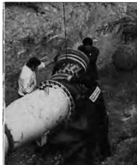
Obr. 2a. Vkládání ježka do potrubí
