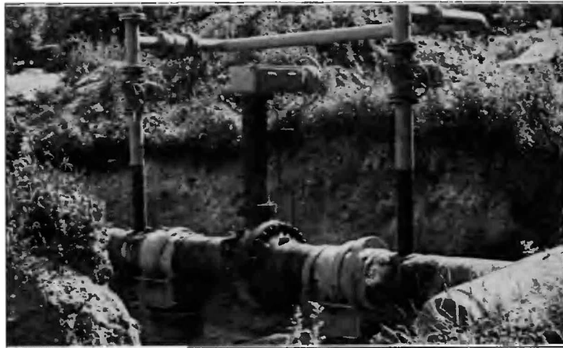
Obr. 5. Nové osazené trasové uzávěr DN 600 před zasypáním
