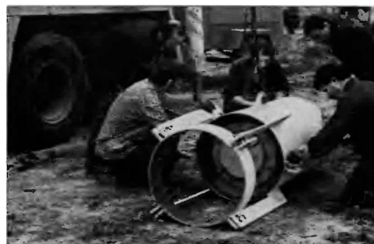
Obr. 2c. Ježek v lapači po průjezdu plynovodem
