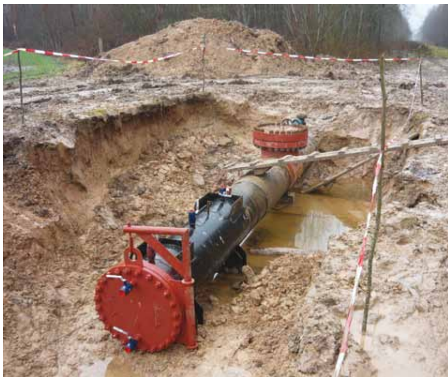
Obr. 2: Dočasná vysílací/přijímací komora CEPS
